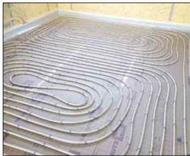
Auch Bodenheizungen werden von der Gassmann GmbH eingebaut.
